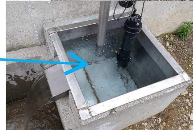
**Permeato finale in C.I.S. e sonda di controllo dell'N-NH4**
